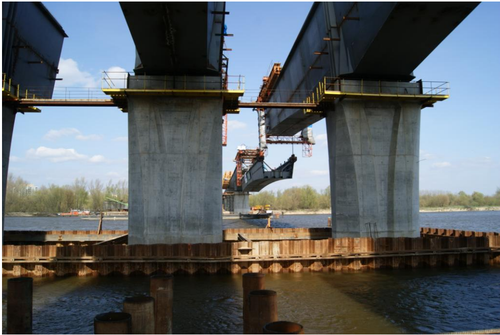
Widok z lewego brzegu rzeki na podporę P40 (nurtową)
