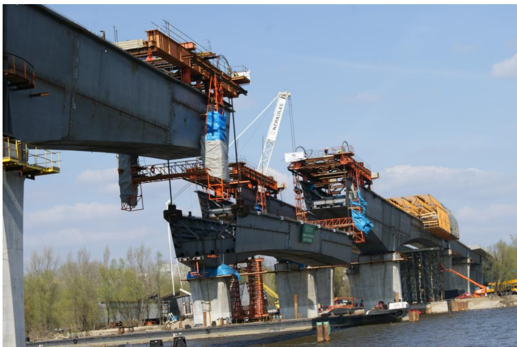
Widok największego segmentu mostu podczas podnoszenia go z barek
