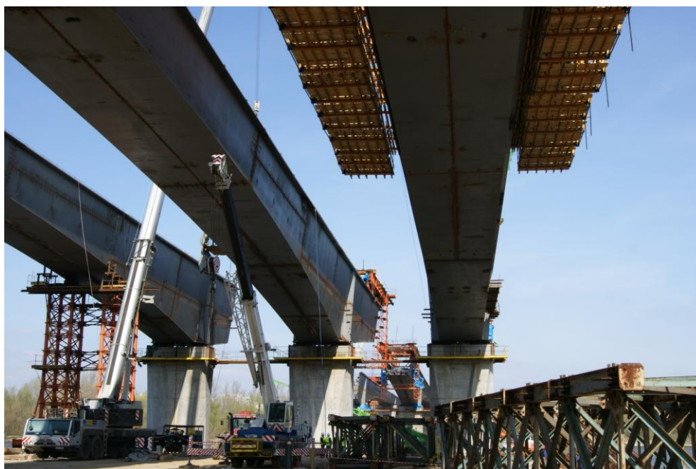
Widok na lewobrzeżną część konstrukcji mostu; w tle podnoszony segment nurtowy
