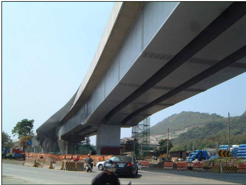
Fot.8 – Wiadukt nad ulicą (konstrukcja stalowa skrzynkowa)
