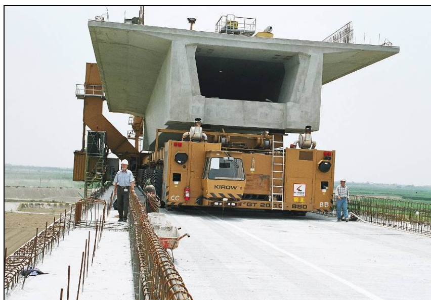
Fot.4 – Transport przęseł prefabrykowanych (pojazd Kirov o nośności 9 MN)
