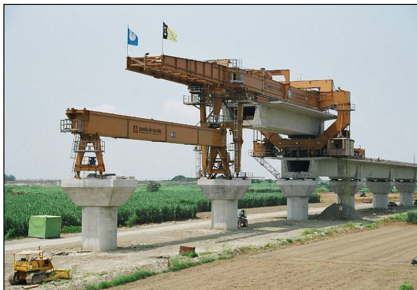
Fot.3 – Montaż przęseł prefabrykowanych (suwnica przestawna)
