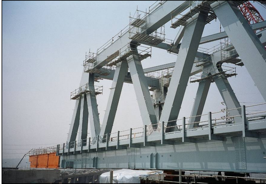
Fot. 7 – Montaż dźwigara kratowego dużej rozpiętości
