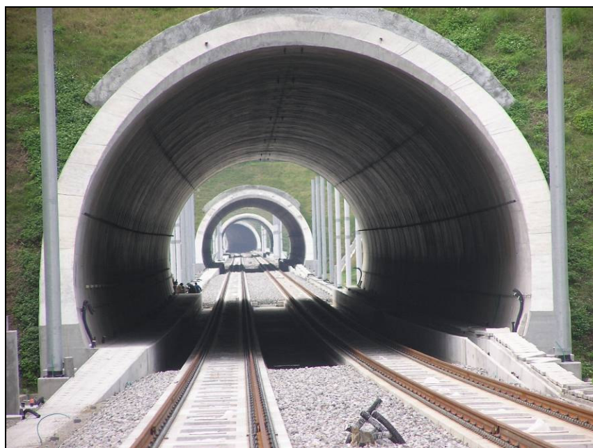
Fot.9 – Typowy tunel dwutorowy
