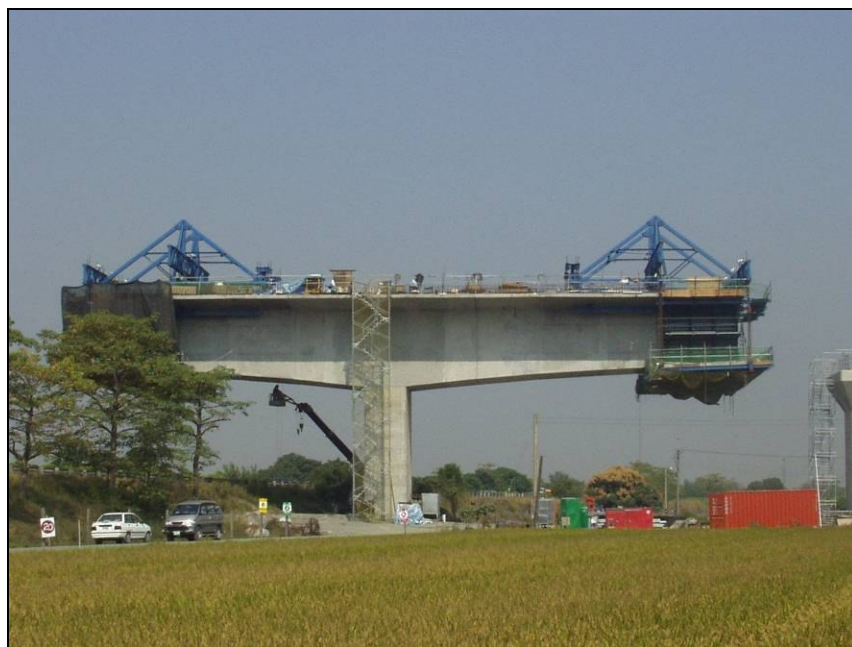
Fot.5 – Montaż metodą nawisową
