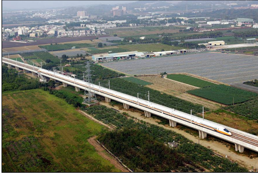
Fot. 12 – Widok pociągu na wiadukcie
