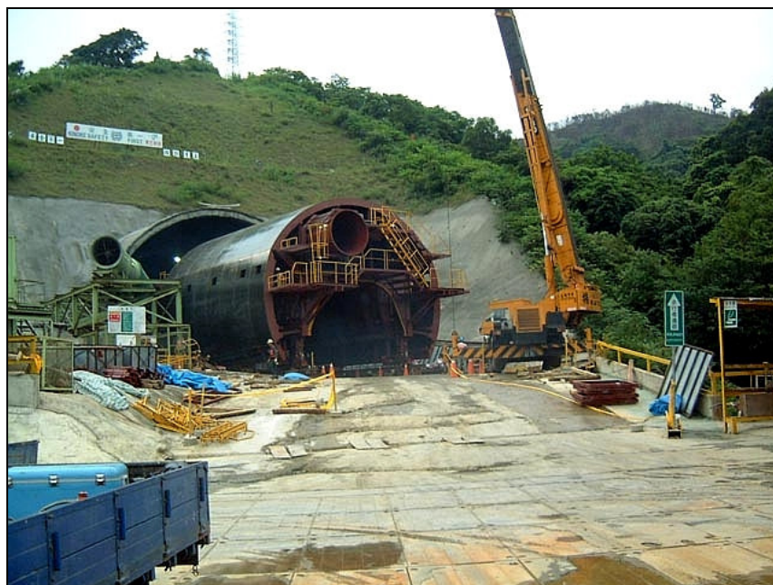
Fot.8 – Deskowanie przesuwne do obudowy stałej tunelu
