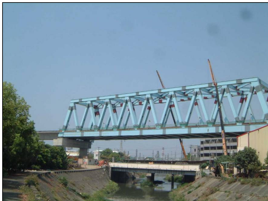
Fot.6 – Przęsło stalowe 100 m rozpiętości
