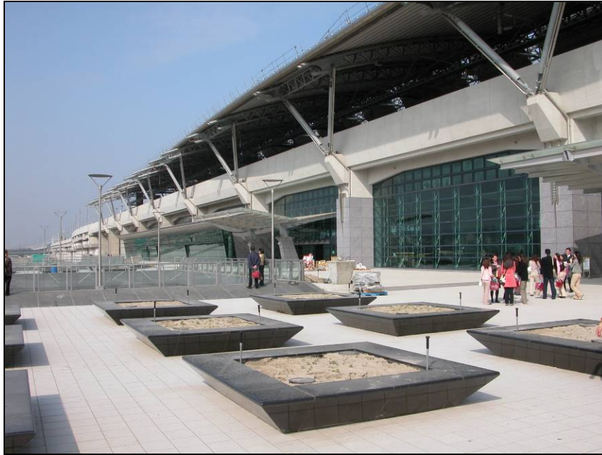
Fot.10 – Widok stacji kolejowej w Tajchung
