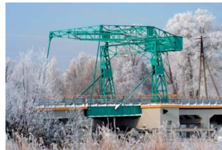
III nagroda – Piotr Sosnowski Most na Wiśle Królewieckiej w Sztutowie
