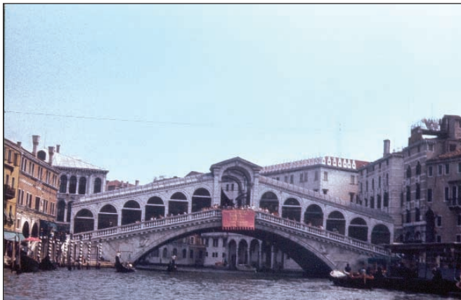
Fot. 4. PONTE RIALTO – obecnie
