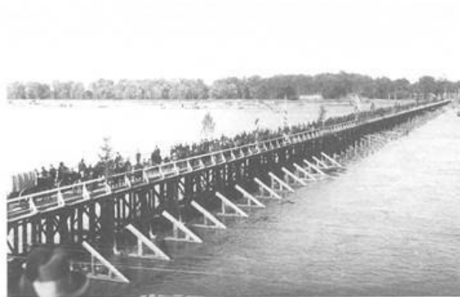
Most drewniany na palach zbudowany w 1915 r. obok mostu Kierbedzia (Arch. Państwowe m. st. Warszawy)
