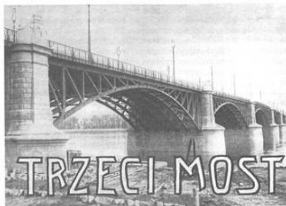
Widok mostu im. ks. J. Poniatońskiego (238: 1913 I s. 368)
