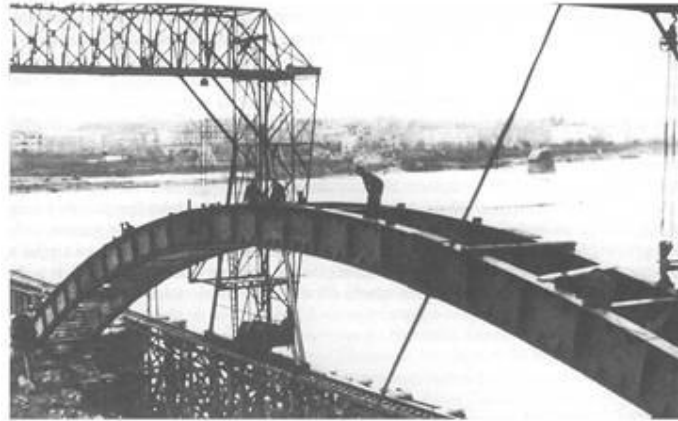
Ustawianie łuku przęsła mostu Poniańskiego (Arch. Papiatwowe m. st. Warszawy)
